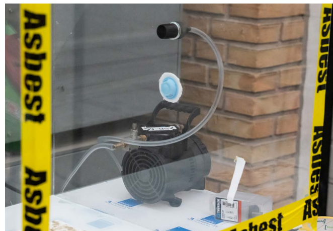
Messgeräte, die an eine Box für Asbestluftmessungen angeschlossen sind
